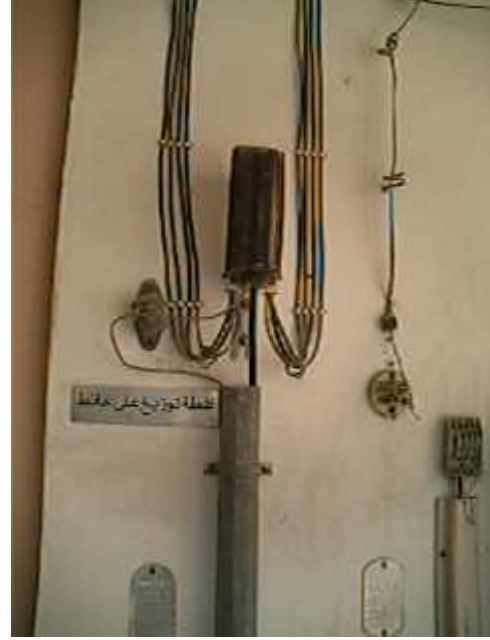
شكل ( ٥ ) يوضح أنواع وحدة صندوق التوزيع الموجود على مباني المشتركين
